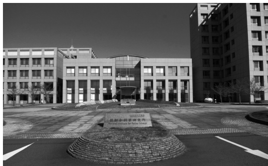
写真1 図書館棟と研究所正面玄関
