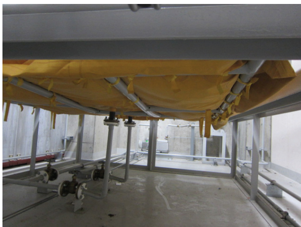
図4 下面の鉄枠も湾曲
