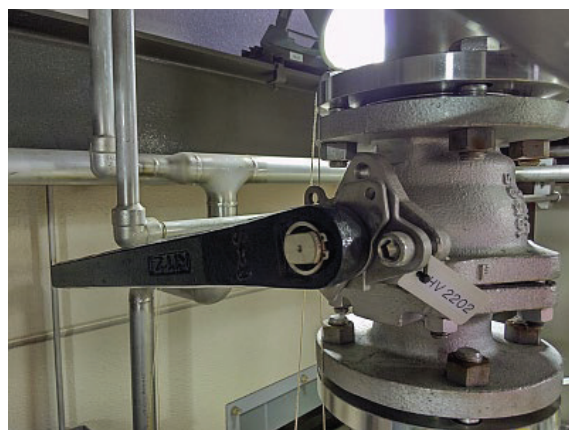
図5 この角度でガスが流れ始めたので待機した
