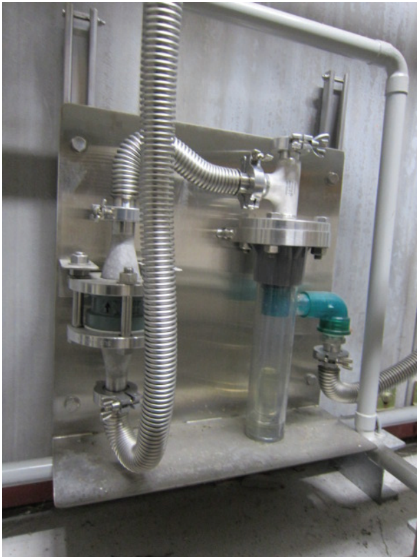
図1 油封入式安全器
