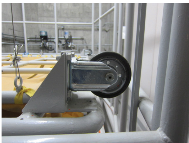
図5 鉄枠の湾曲でガイドレールから外れた車輪
