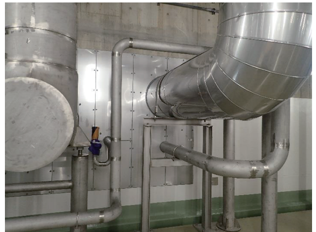
図11. 冷却用配管貫通用開口部
