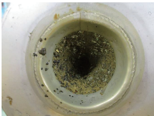
図6. ストレーナー内部の汚れ
