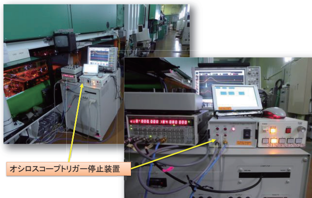
図 10 前置増幅器列に設置したトリガー停止装置
