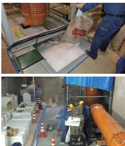
図 11. ポリエチレンペレット充填と板の加工
