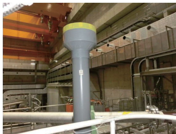
図 6. ガイドパイプ (上部)
