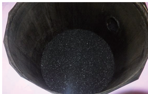
図1. 油分離器の内部(4次セパレータ)
