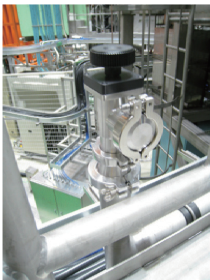
図 5. 作業用排気配管取り合いバルブ
