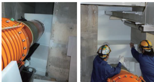
図 10. ポリエチレン板での閉止作業
