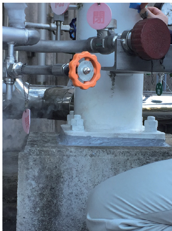
図4. 液化窒素CEの脚部の隙間にシリコンコーキング材を充填した様子。
