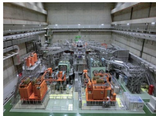
図2. 大型ヘリカル実験棟本体室
