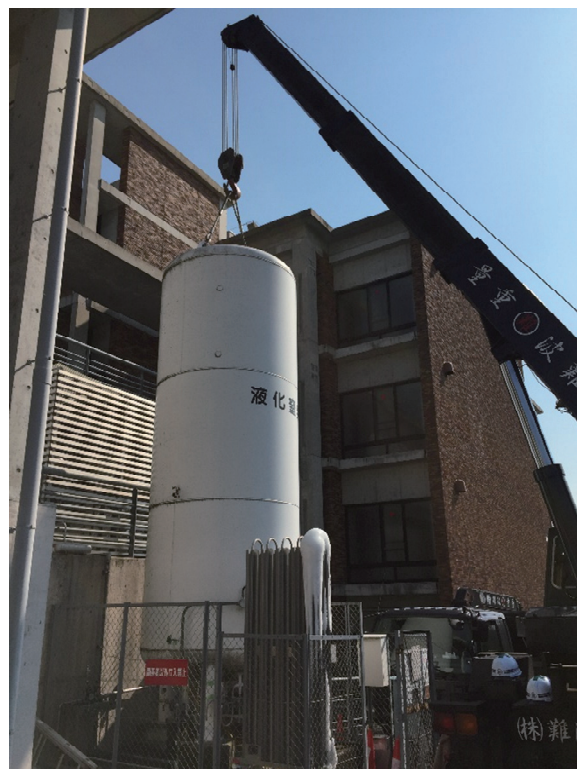
図3. 転倒防止措置として、液化窒素CEをクレーンで保持した様子。
