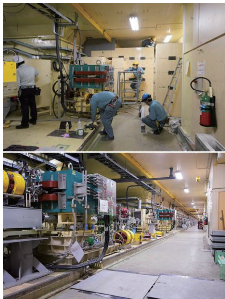
図 2. 入射器上下流の壁撤去前と撤去後
