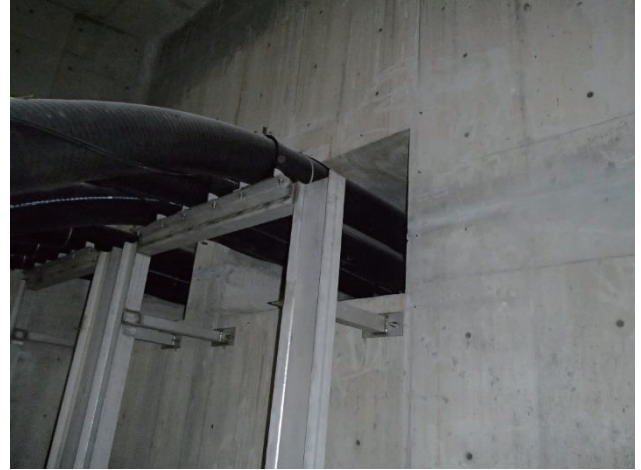
図10. 超伝導バスライン貫通用開口部
