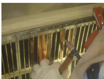
図 4-2. アンテナ先端部の補修
