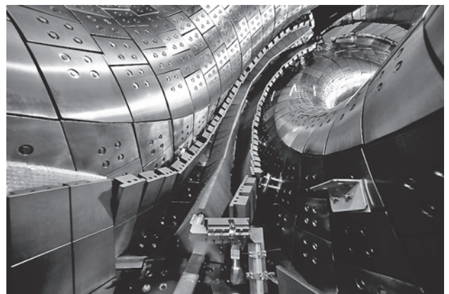
図17 改造されたダイバータ。ヘリカルコイル間の敵に沿って、ダイバータ板が両側に設けられ、その間にドーム構造を持つ。
